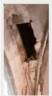
Des infiltrations insidieuses avaient peu à peu fragilisé les voûtains de briques, de plâtre et de bois.
